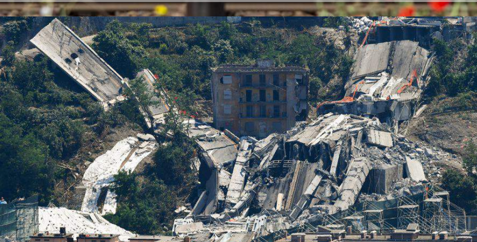
Effondrement partiel du Pont de Morandi, Gênes – août 2018
